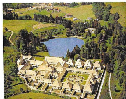
Vue générale de l'ex-chartreuse du Reposoir (Haute Savoie)
